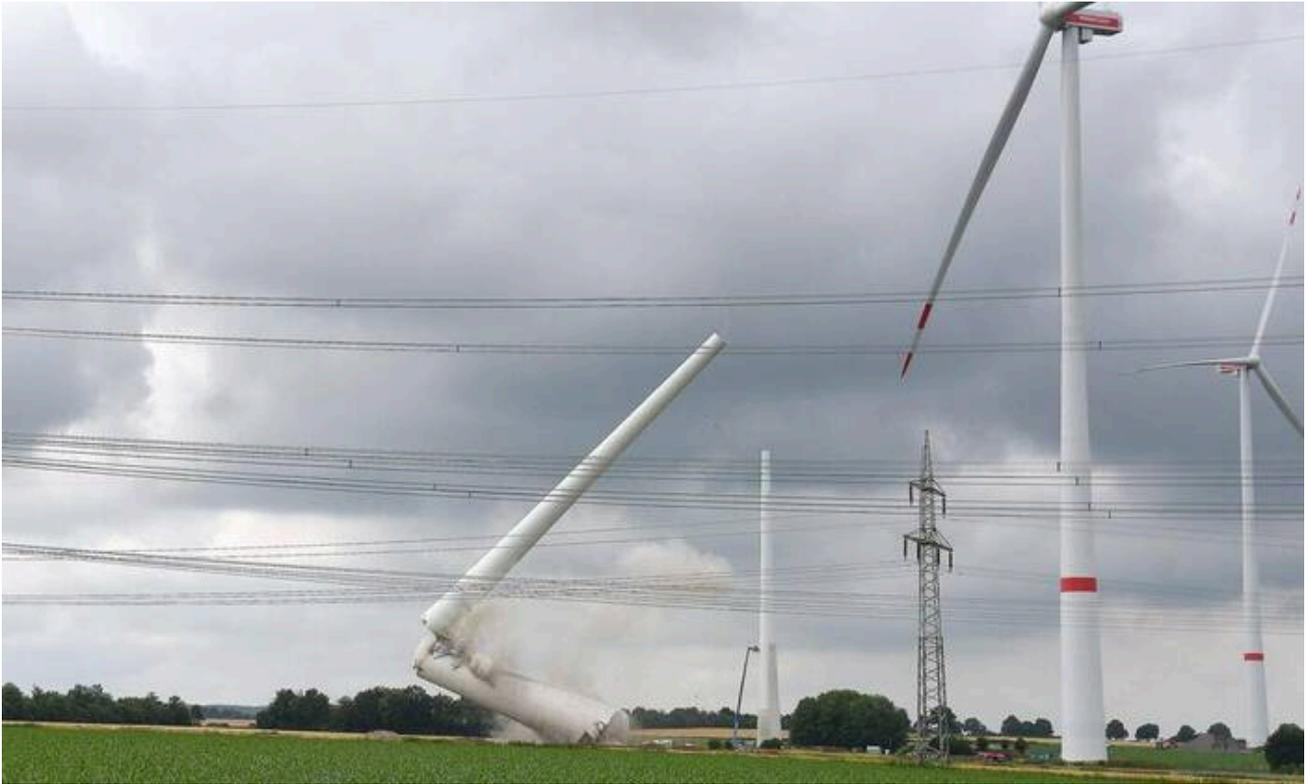
Für den Rückbau der alten Windräder in Mawicke wurde der erste Turm gesprengt. FotoS:
